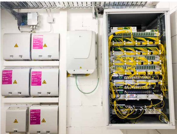
Abbildung 51: FTTH-Wohnanlage mit 60 WE, Nutzung von Glasfaser-Netzinfrastrukturen unterschiedlicher Anbieter; Netzkomponenten für PON (links) und PtMP mit aktiver Technik für IP und DVB-C/CATV (rechts)
