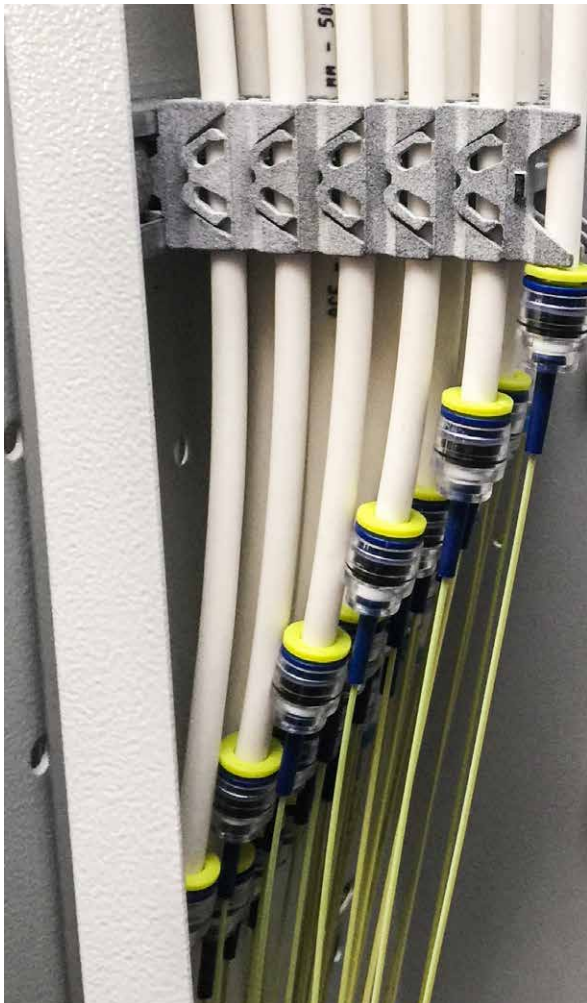
Abbildung 39: Darstellung der Installationsleitung zu den WÜPs
