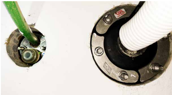
Abbildung 24: Einspartenhauseinföhrung für einen bzw. zwei Netzbetreiber
