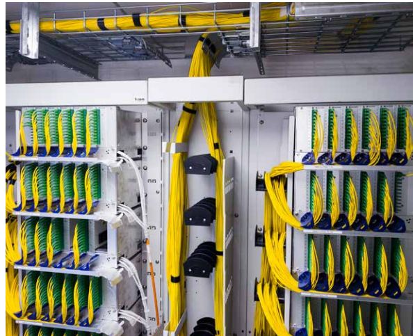
Abbildung 52: Einzelkabel-Management zur Anbindung der WE (FTTH)
