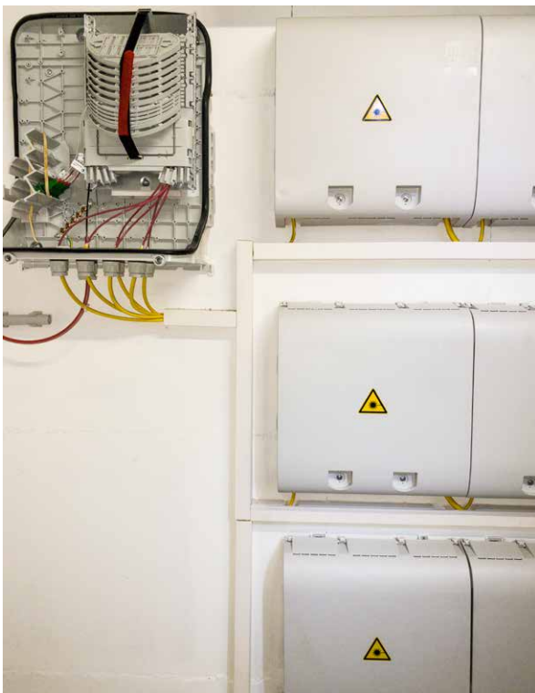
Abbildung 37: GF-AP für eine PON-Verteilung
