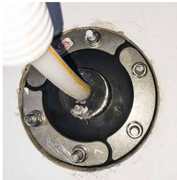
Abbildung 23: Einspartenhouseinführung für einen Netzbetreiber
