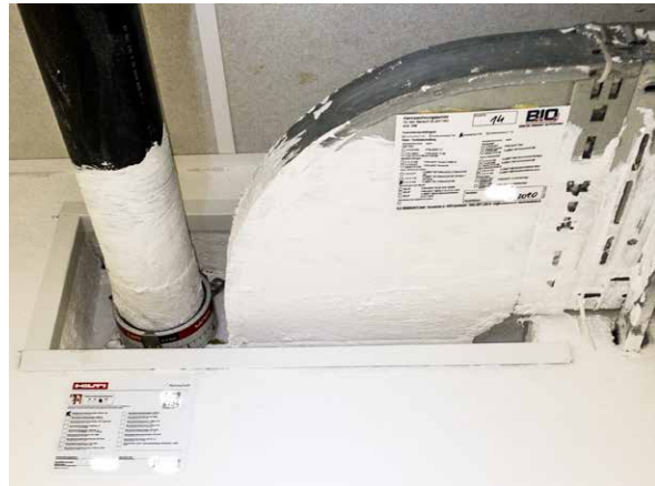
Abbildung 64: Brandschottung für eine Kabelwanne und ein Abflussrohr
