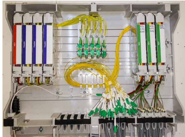
Abbildung 44: HFC-Gebäudeverteiler mit darüberliegendem Kabelführungssystem/Kabelwanne
