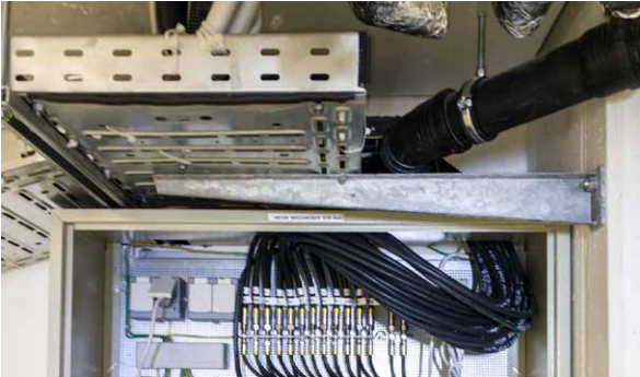
Abbildung 44: HFC-Gebäudeverteiler mit darüberliegendem Kabelführungssystem/Kabelwanne
