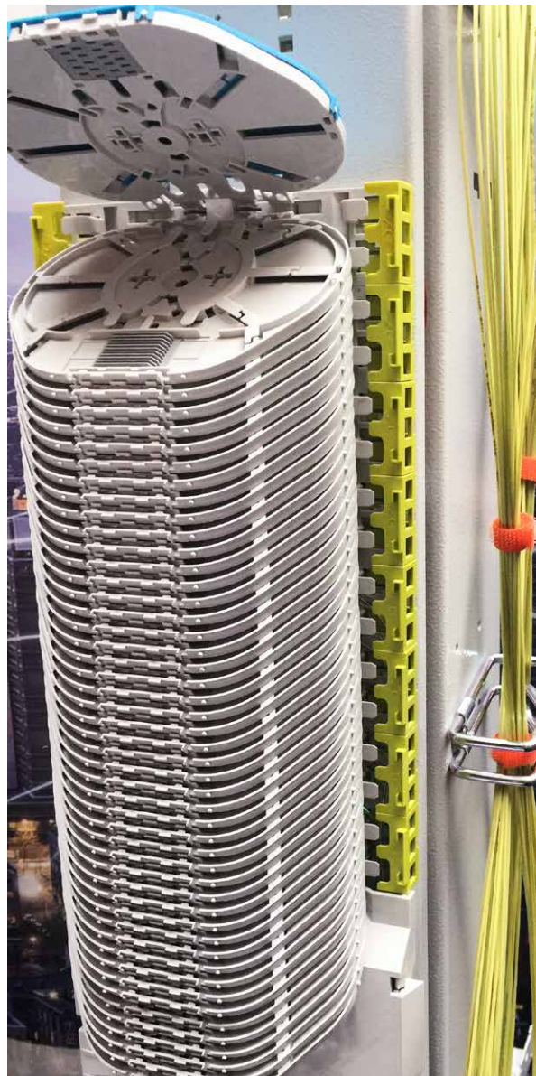
Abbildung 38: Einzelfaser-Management am GF-AP für eine PtP-Verbindung
