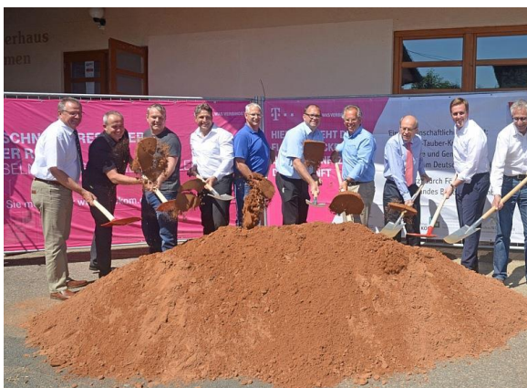
r-l: Bürgermeister Elmar Haas, Bürgermeister Ludger Krug (Königheim), Dr. Veit Steinle (Regionalleiter atene KOM, hoheitlich beliehener Projektträger des BMVI) Landrat Reinhard Frank sowie weitere Projektbeteiligte beim Spatenstich für Ausbaubereich 8 des Main-Tauber-Kreises (Baden-Württemberg) in Königheim am 08.05.2018. Fotocredit: Landratsamt Main-Tauber-Kreis.
