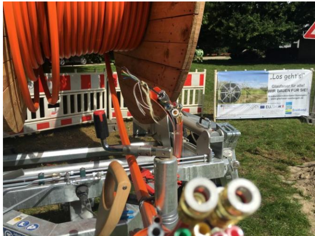
Foto: Die Kabel für den Breitbandausbau im Amt Südangeln stehen bereit. Fotocredit: atene KOM GmbH
